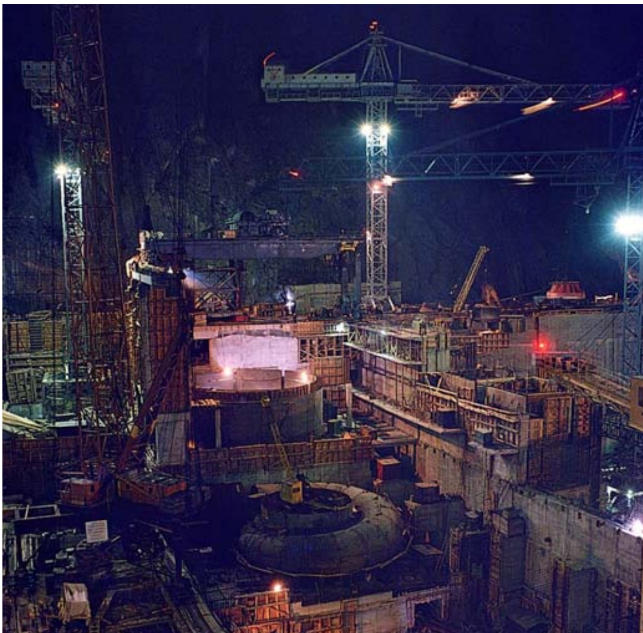
Рис. 3.6 Внешний вид строящейся спиральной камеры гидроагрегата №-2 в период монтажа
